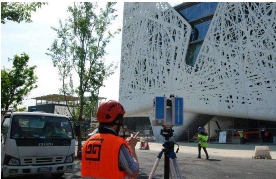
*Figura 2 Operazioni di rilevamento laser scanner statico presso il cantiere di Palazzo Italia a Milano (Courtesy of GEXCEL srl)*
